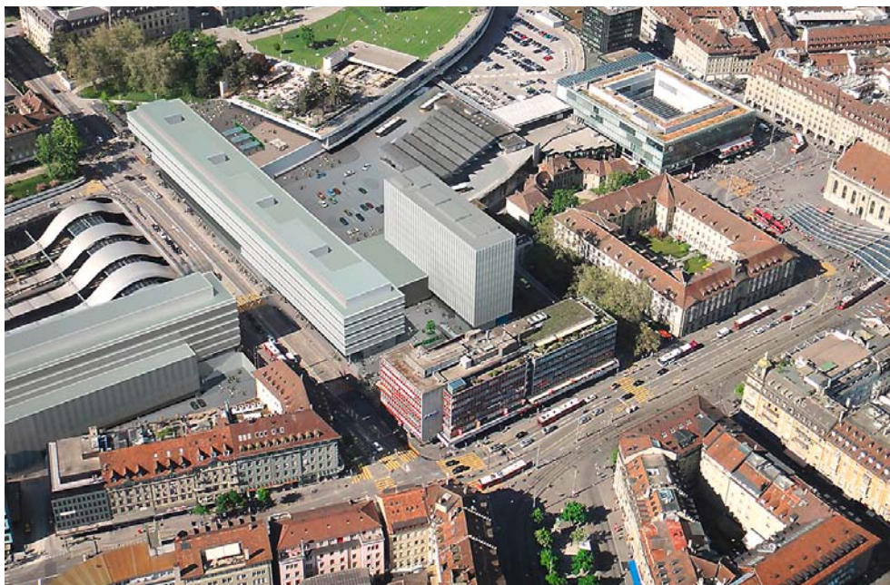
Auf der Post-Parc-Baustelle in Bern mussten Angestellte der Firma Emme Suisse zu Dumpinglöhnen arbeiten. Bild: zVg
